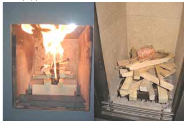
Abb. 26: Holzaufschichten im kalten Schornstein
