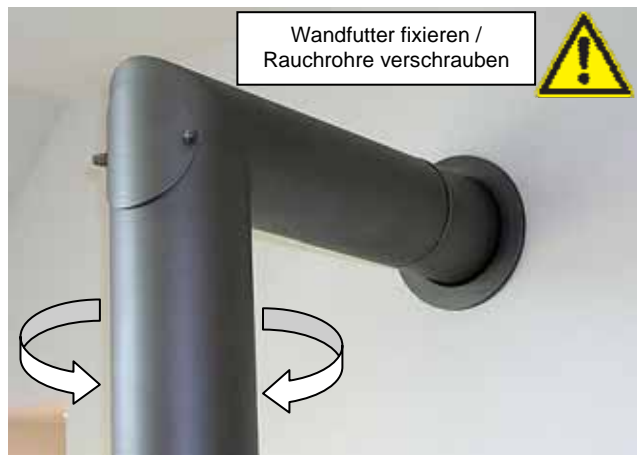
Abb. 19: Anschluss Rauchrohr an Wandfutter
