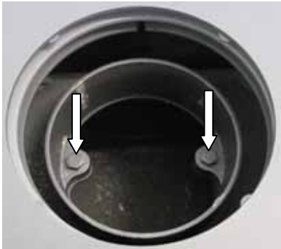
Abb. 6: Schrauben Rauchrohrstutzen
