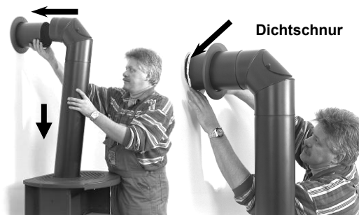
Abb. 5: Montage Rauchrohr
