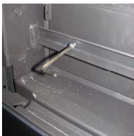
Abb. 30: Demontieren U- Profil
