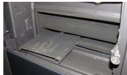
Abb. 32: Entfernen Stahlblech Umlenkungen
