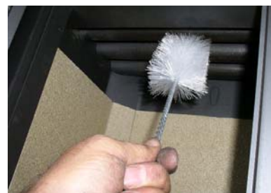
Abb. 35: Reinigung Wärmetauscher
