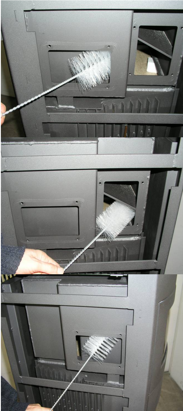
Abbildung 18: Reinigung Wärmetauscher
