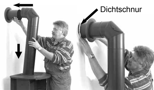
Abbildung 29: Montage Rauchrohr
