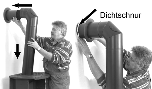
Abb. 8: Montage Rauchrohr
