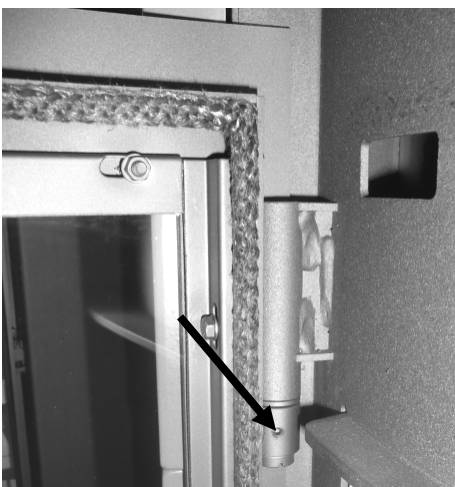
Abb. 8: Feststellschraube KK 50
