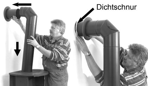
Abb. 6: Montage Rauchrohr
