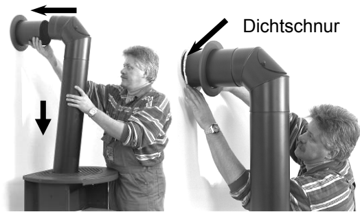
Abb. 7: Montage Rauchrohr
