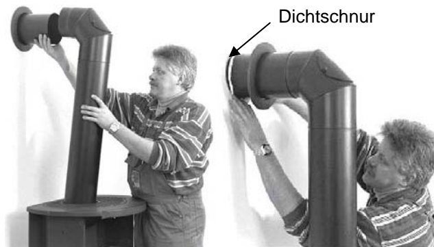
Abb. 14: Installation Verbindungsstück
