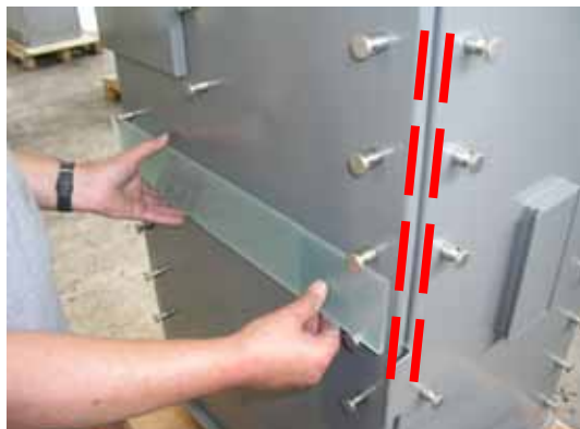
Abb. 31: Ausrichten Dekorglas
