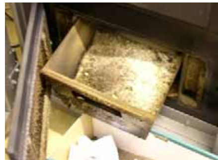
Abb. 108: Entnahme der Aschelade
