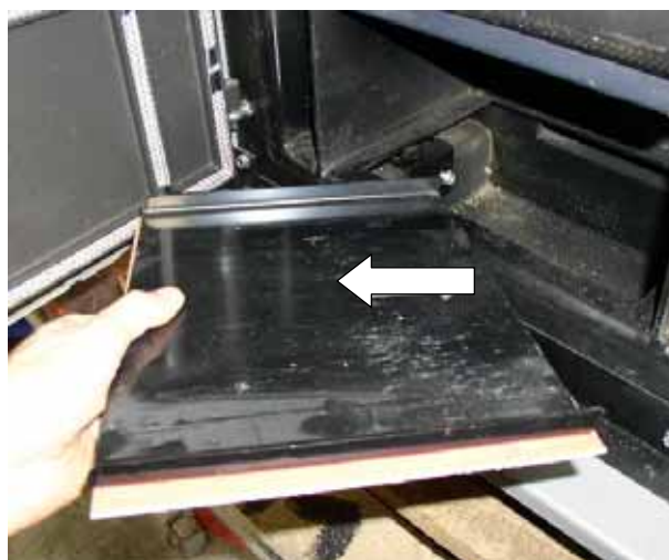
Abb. 138: Entfernen Abdeckplatte Heizgassammler
