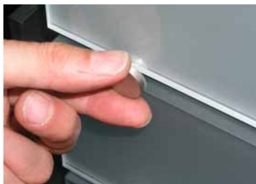
Abb. 34: Detail Verschraubung Dekorglas
