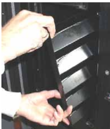
Abb. 133: Entnahme Turbulator
