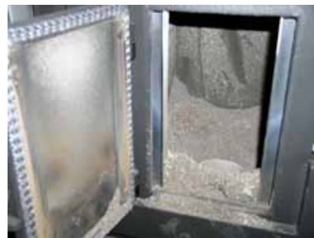
Abb. 93: Verschmutzter Feuerraum
