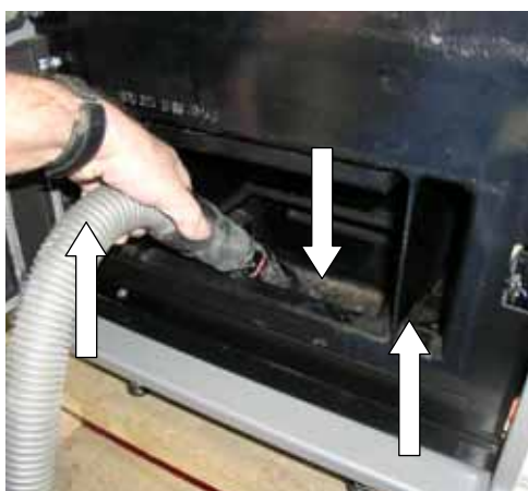
Abb. 137: Aussaugen Heizgassammler und Heizgaszüge
