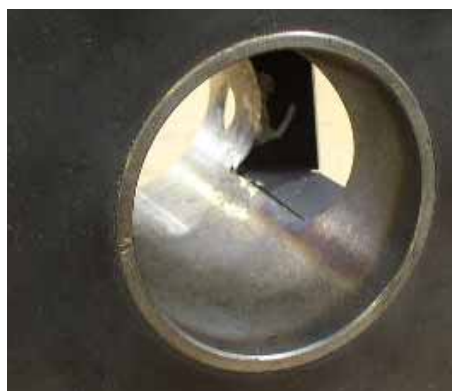
Abb. 115: Gereinigter Brennerkopf
