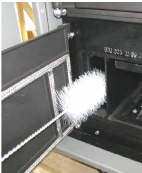
Abb. 136: Reinigung Heizgaszüge unten
