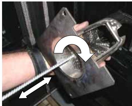
Abb. 113: Reinigung des Brennerkopfes
