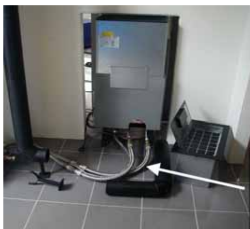
Anschluss Vor- und Rücklauf mit flexiblen Schläuchen (gasdichtes Edelstahlrohr - siehe Zubehörprogramm)
