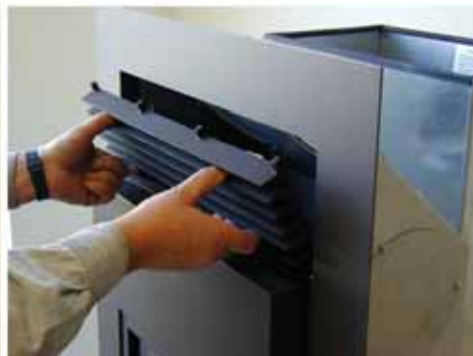
Frontgitter abschrauben und entfernen.
