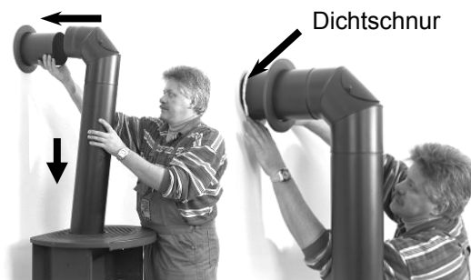
Abb. 5: Montage Rauchrohr
