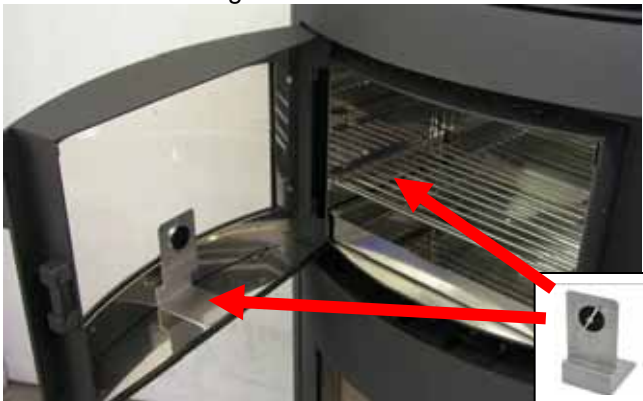
Abbildung 11: Positionen Thermometer
