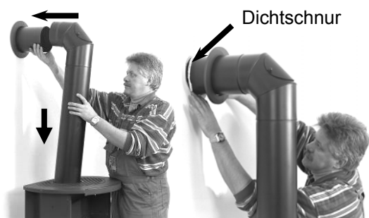
Abb. 9: Montage Rauchrohr
