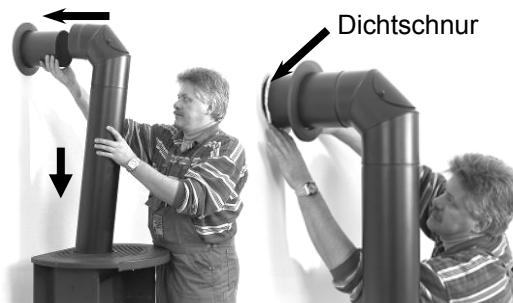
Abb. 6: Montage Rauchrohr
