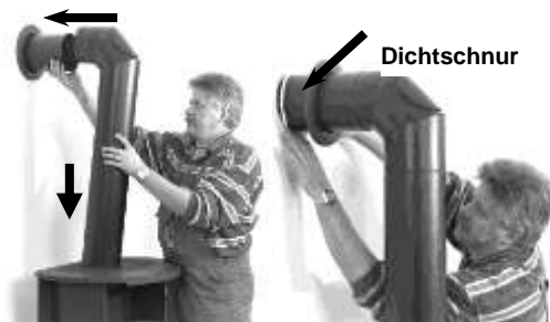
Abb. 7: Montage Rauchrohr
