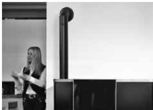
Vertikaler Rauchrohranschluss
