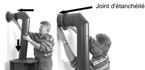
Fig. 5 : montage du tuyau de fumée
