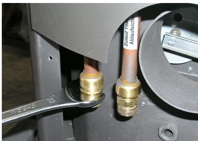
Fig. 19 Raccords hydrauliques vissés
