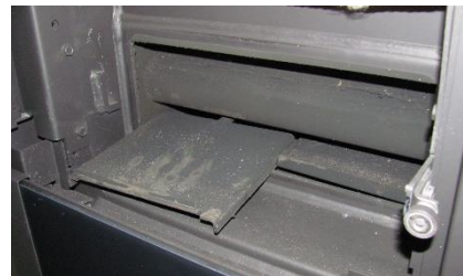
Fig. 34 : retrait des déflecteurs en acier
