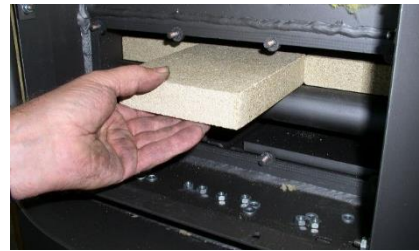
Fig. 33 : retrait des déflecteurs en vermiculite
