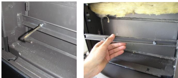
Fig. 32 : démontage du profilé en U
