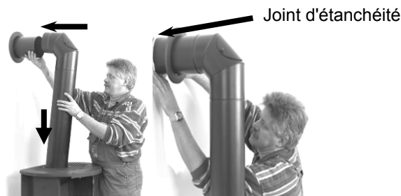
Fig. 5 : montage du tuyau de fumée
