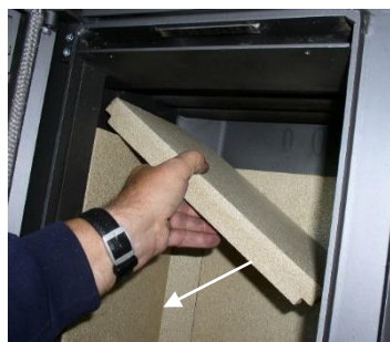
Fig. 33 Retirez la plaque de déflection de l'échangeur thermique
