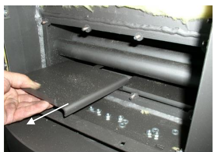
Fig. 30 Retirez les 2 déflecteurs inférieurs (respectez la position de montage)
