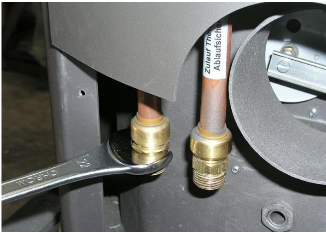
Fig. 11 Raccords hydrauliques vissés
