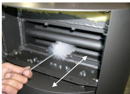
Fig. 32 Brossez soigneusement les tubes de l'échangeur thermique
