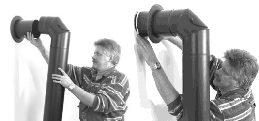
Fig. 10 : raccordement du tuyau de fumée à la cheminée
