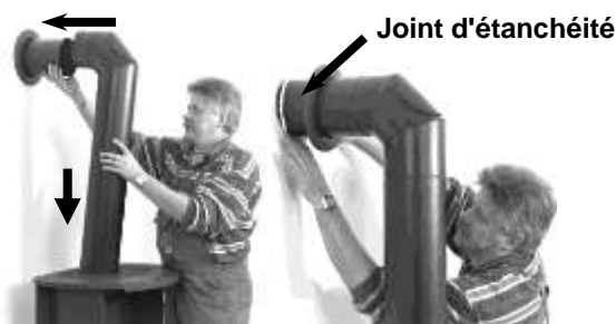
Fig. 7 : montage du tuyau de fumée
