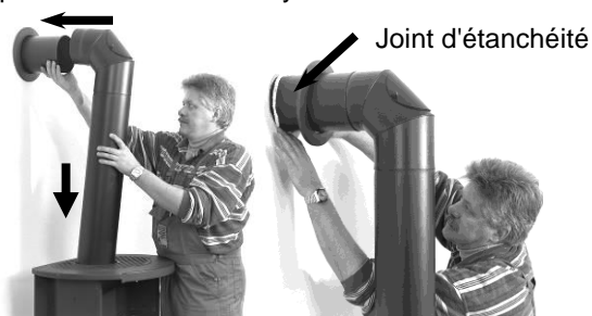
Fig. 7 : montage du tuyau de fumée
