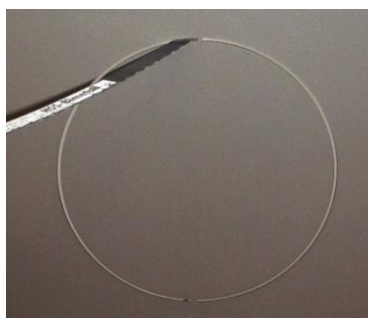
Fig. 11 : ouvrir l'orifice
