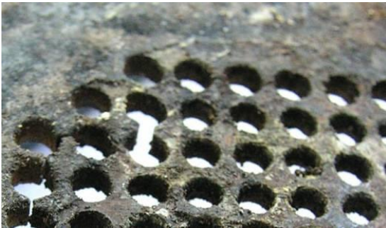
Fig. 78 : matériau de la grille fissuré
